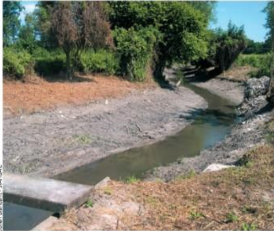
L'ancienne retenue du seuil après ouverture des madrers, juin 2008.
